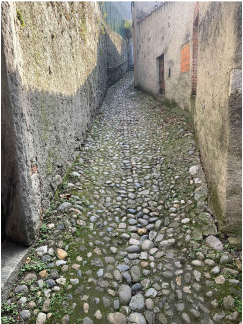
Acciottolato. Previsto segnapasso asimmetrico su un solo lato della strada, stante la conformazione a dorso di mulo rovesciato (ovvero a conca) della via
